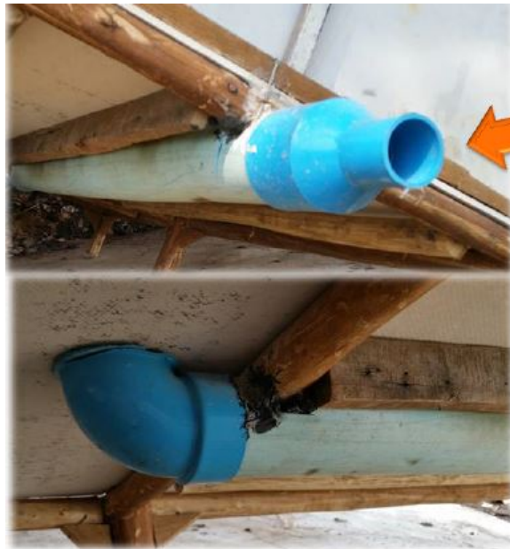
วางท่อระบบเติมอากาศใต้พื้นโรงปุ๋ยหมัก
