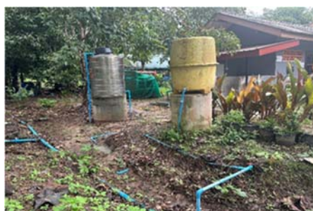
ภาพที่ ๔ การวางระบบน้ำ การสูบน้ำและสารละลายผ่านท่อส่งน้ำ
