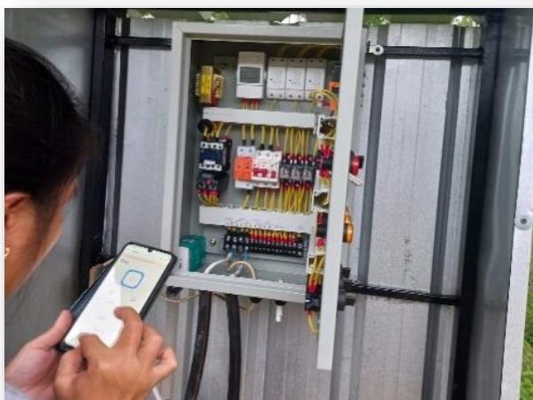
ภาพการใช้ Smart Farm Kit ควบคุมระบบการให้น้ำแบบอัตโนมัติ
